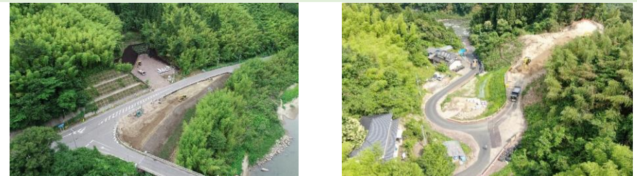
国道349号の別線(山側ルート)整備の様子
