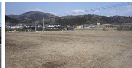
解体・撤去後の町営竹谷住宅
