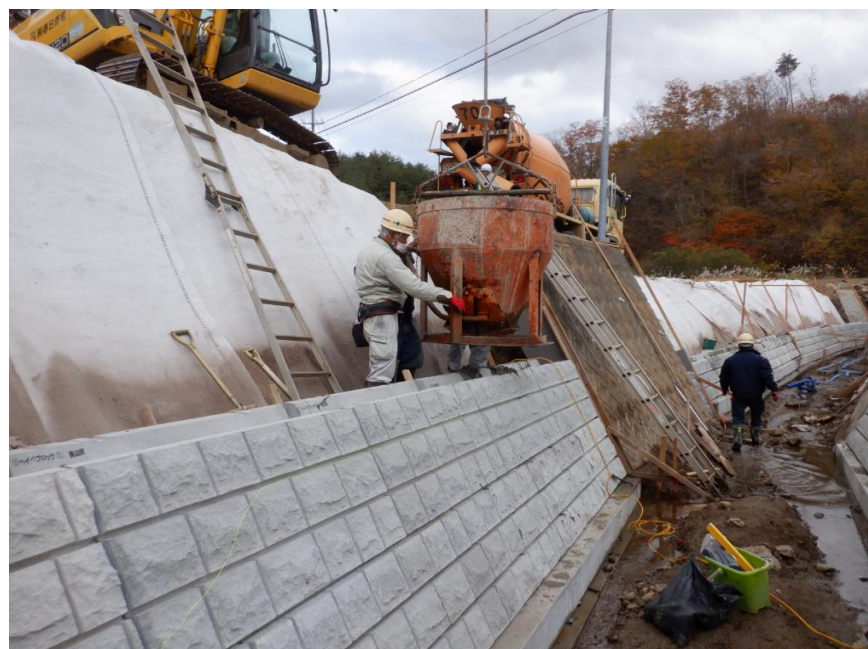
犬飼川 (筆甫字広町) 復旧工事の様子
