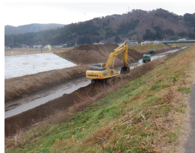
新川 (竹谷橋上流) 河道掘削の様子
