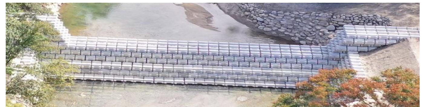
内川 (滝原地区) の床固工の様子
