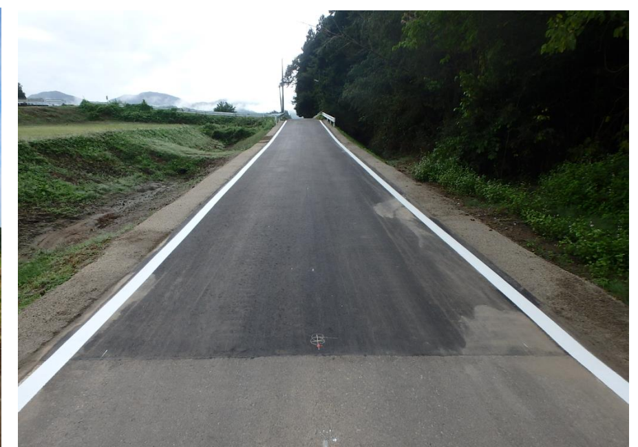
雉子尾山屋敷線 (金山字河原) 復旧後の様子
