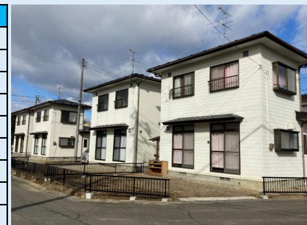
復旧後の町営金山住宅
