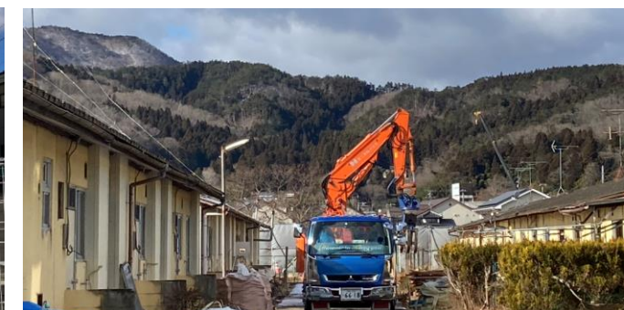
町営神明住宅の解体工事の様子
