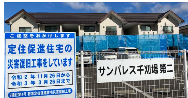
サンパレス千刈場の復旧工事の様子
