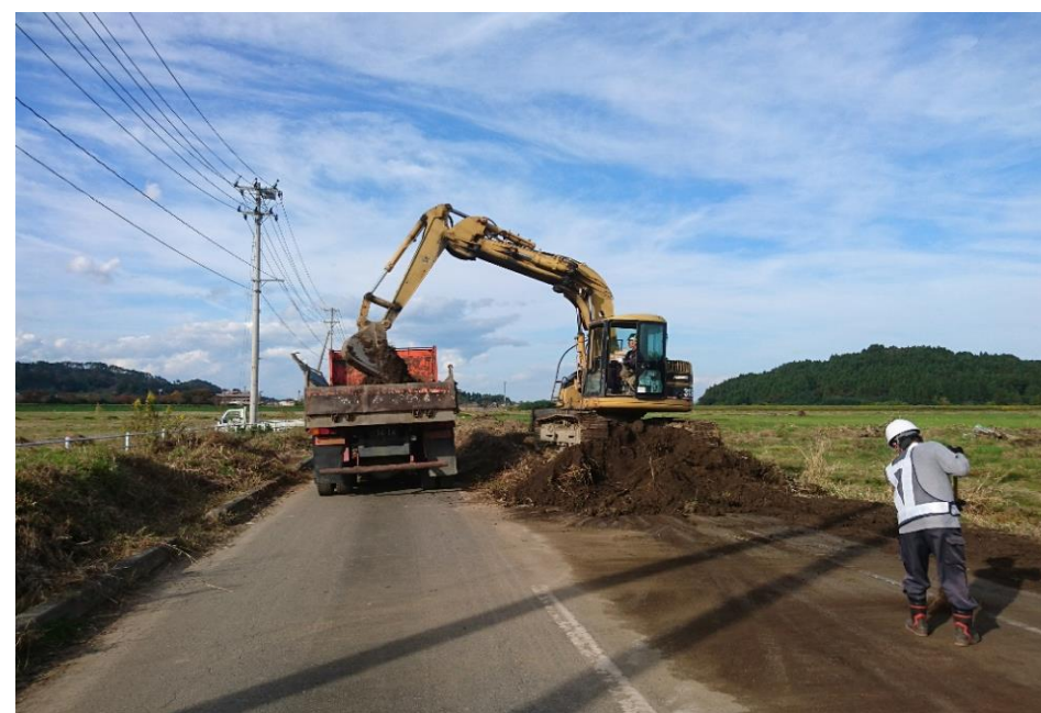
鳥屋竹谷線 (丸森字土橋) 復旧工事の様子
