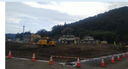
町営竹谷住宅建設中の様子
