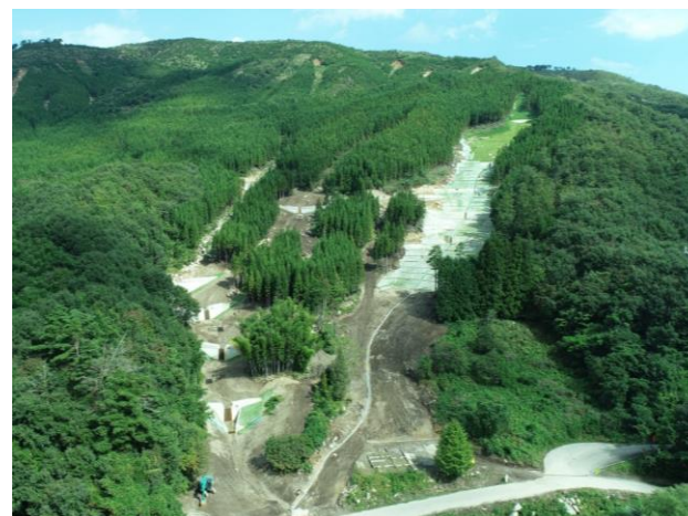
丸森字子安地区治山工事完了後の様子
