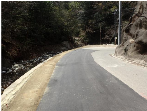
町道羽出庭線(丸森字早坂)復旧後の様子
