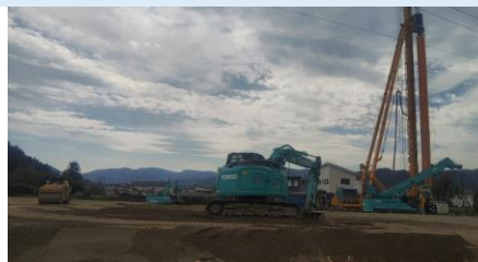
災害公営住宅(神明北)建設中の様子
