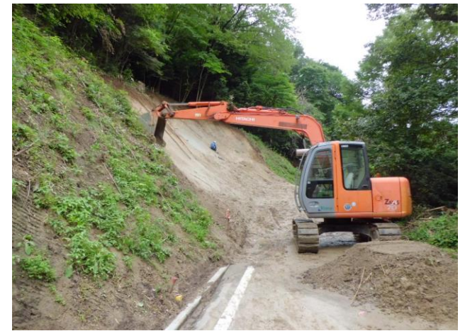
林道西畑線(館矢間山田)復旧中の様子
