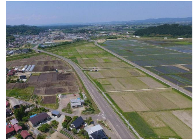
丸森字竹谷地区農地復旧後の様子
