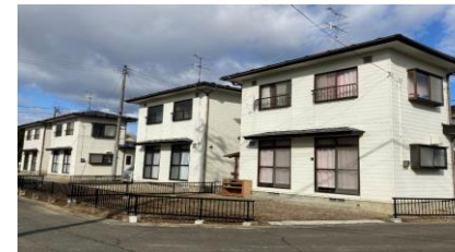
復旧後の町営金山住宅
