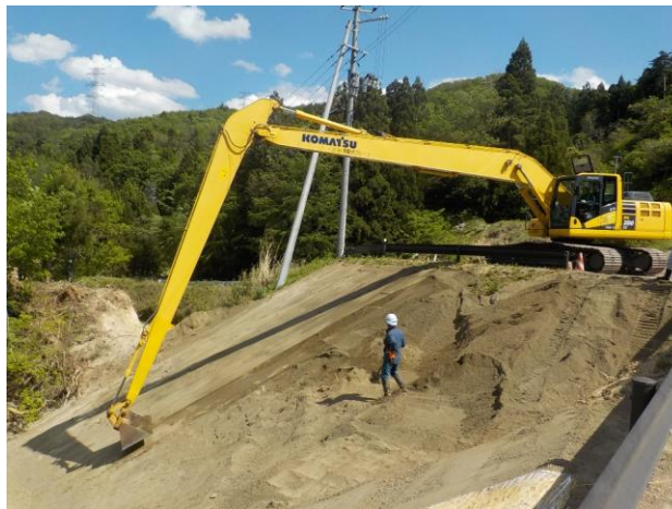
町道羽出庭線(丸森字羽出庭)復旧工事の様子
