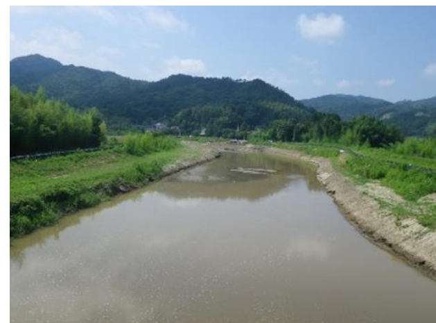
内川 (赤堀橋上流) 河道掘削後の様子
