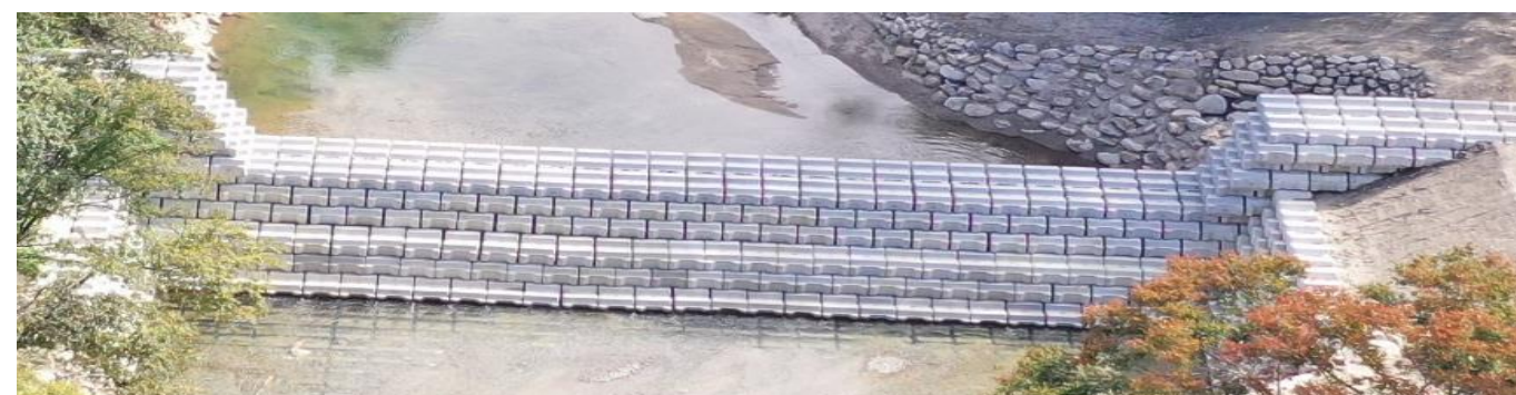
内川 (滝原地区) の床固工の様子
