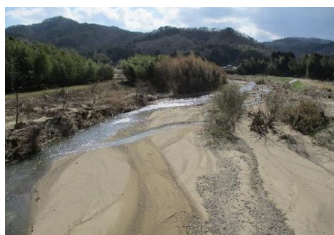
内川 (赤堀橋上流) 河道掘削前の様子
