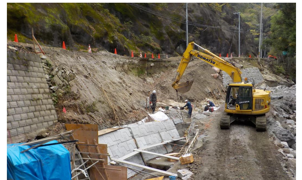
羽出庭線 (早坂) 道路復旧工事の様子
