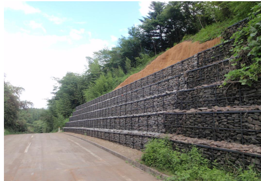
農道 (下梅ヶ作地区) 復旧後
