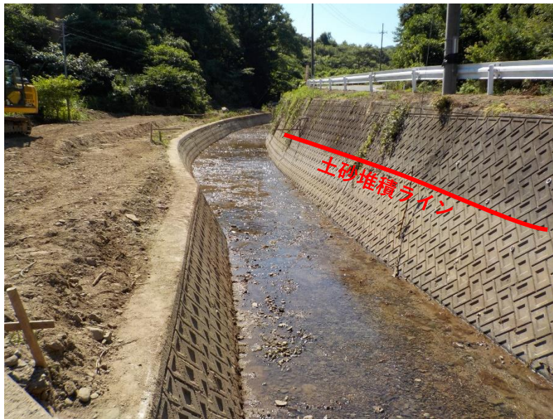
犬飼川 河川掘削状況
