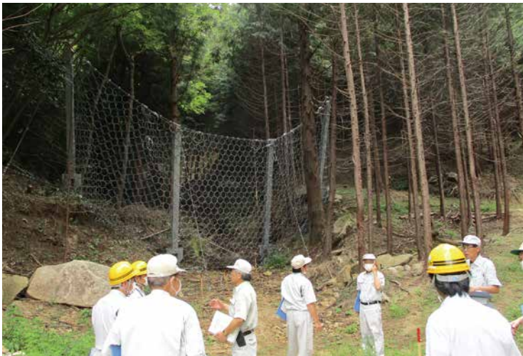
五福谷川流域に設置された強靱ワイヤーネット
