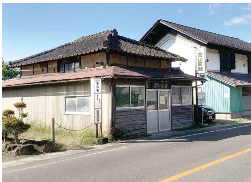
解体予定の金山町駅
