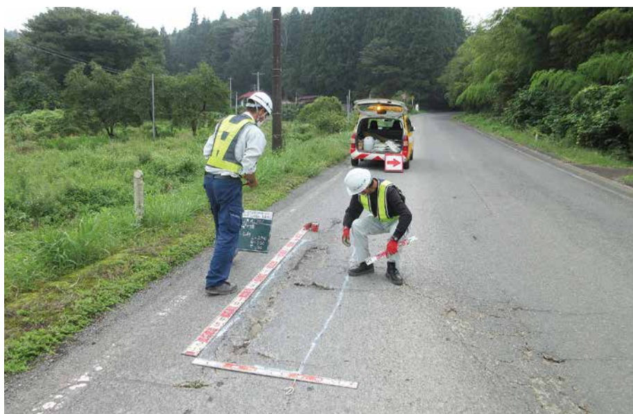
県道丸森梁川線の点検整備をする作業員
