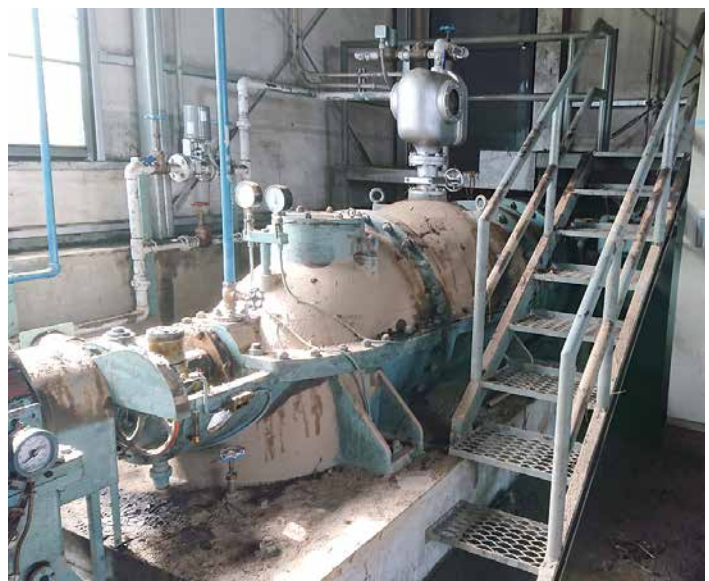
修理を急ぐ800ミリ排水ポンプ（丸森雨水ポンプ場）
