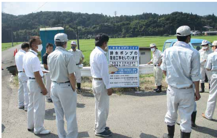
大内清水揚水機場復旧工事
