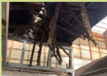
▲巨大な機械で攪拌する
