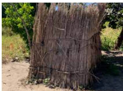
▲村のトイレ・外観。壁が藁。天井なし。
