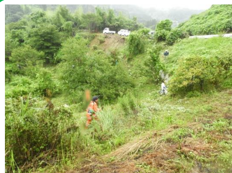
当日の作業の様子
