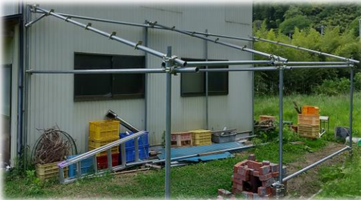
幅6.5mの下屋。もう少し骨を組んで屋根を張り完成予定！
